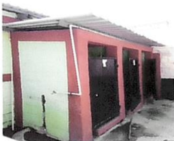
Foto 3: Reparación de tubería de agua en los Sanitarios
