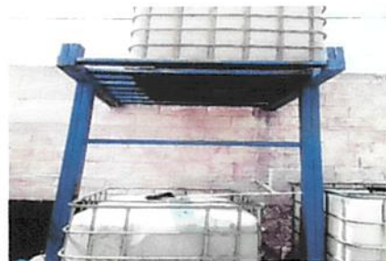
Foto 4: Se repararan las bases para los tinacos de agua.
